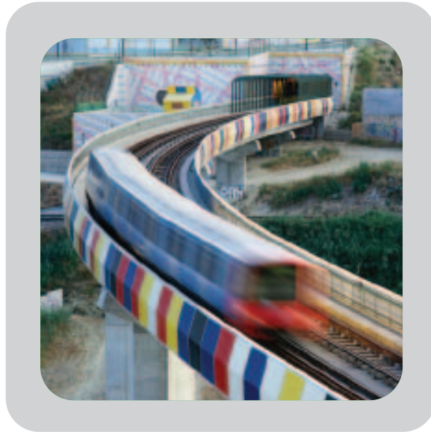
Viaduto das Olaias Olaias viaduct
