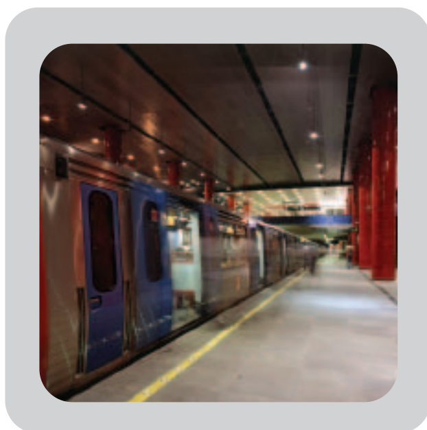
Estação Chelas Chelas station
