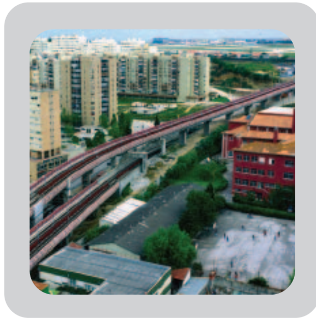
Viaduto do Campo Grande Campo Grande viaduct
