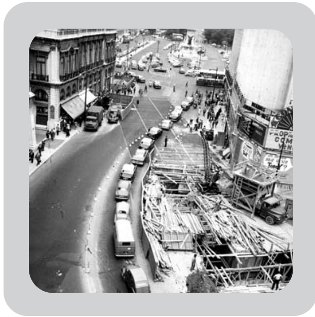
Construção a céu aberto da galeria do Metro na Rua 1ºDezembro.
