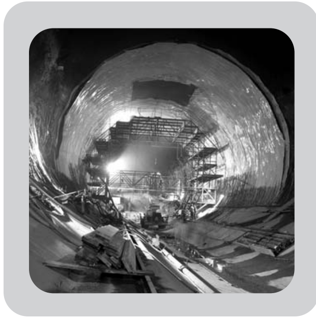
Zona de obra da estação Baixa-Chiado Baixa-Chiado station works
