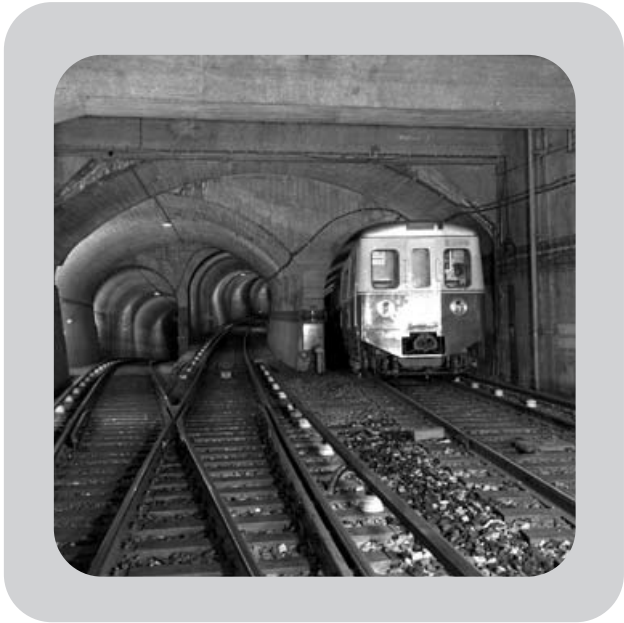
Transição da galeria de via dupla para duas galerias geminadas à entrada do Nó da Rotunda
